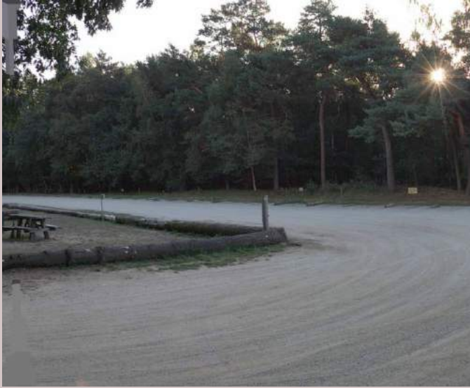
Inrichting halfverharding en boomstammen als markering parkeervoorziening Herperduin
