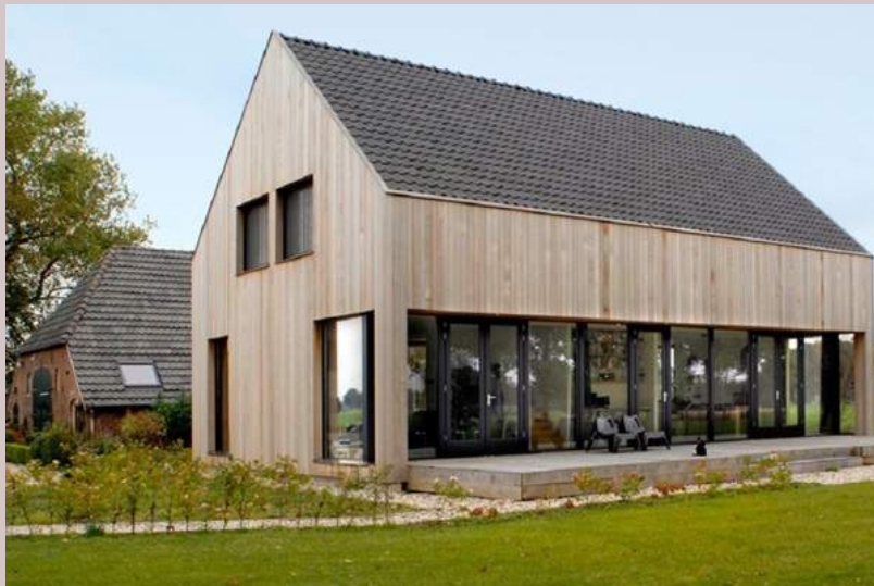
Een schuurwoning met natuurlijke gevels Studio Groen + Schild; Schuurwoning te Okkenbroek
