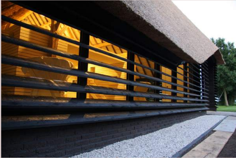
Een Vlaamse schuur met transparante gevel elementen Arend Groenewegen Architecten BNA
