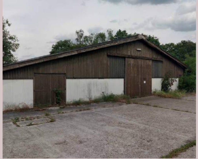
De bestaande schuur van de voormalige proefboerderij kan getransformeerd worden tot parkeerschuur
