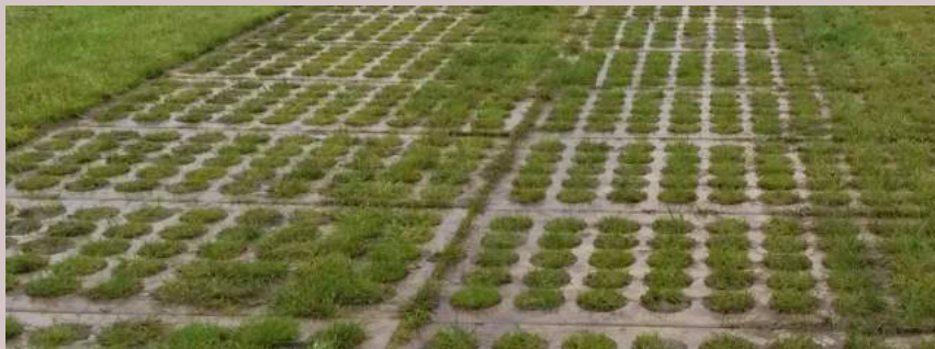
Gebruik van grastegels om kampeerplekken te realiseren
