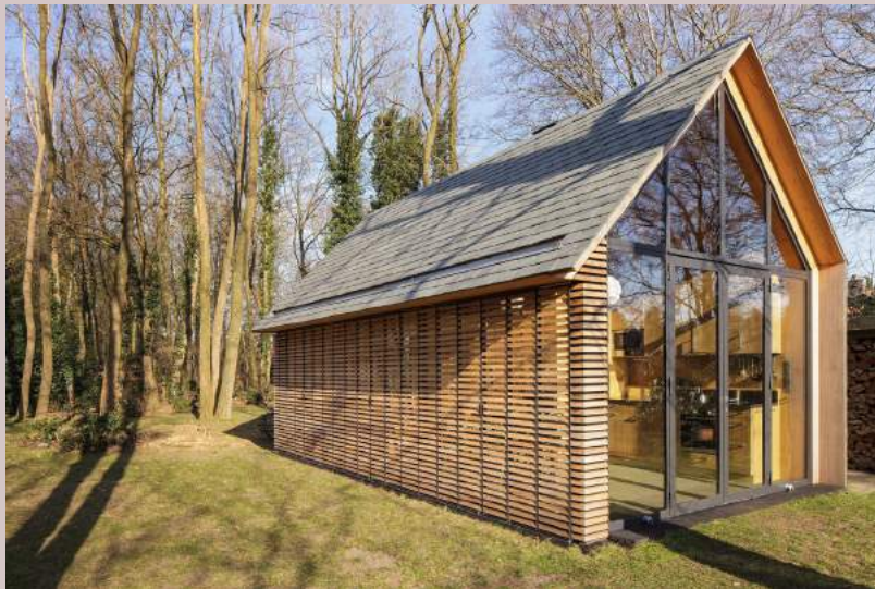
Hoe transparante delen in de gevel verwerkt kunnen worden. Recreatie woning Utrecht, Zecc architecten, Stijnstijl Fotografie & Roel van Norel
